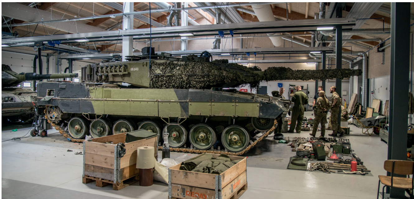
På Dragonkasernen i Holstebro er nyt garageanlæg taget i brug. Foto: Martin Schmidt Jørgensen.
