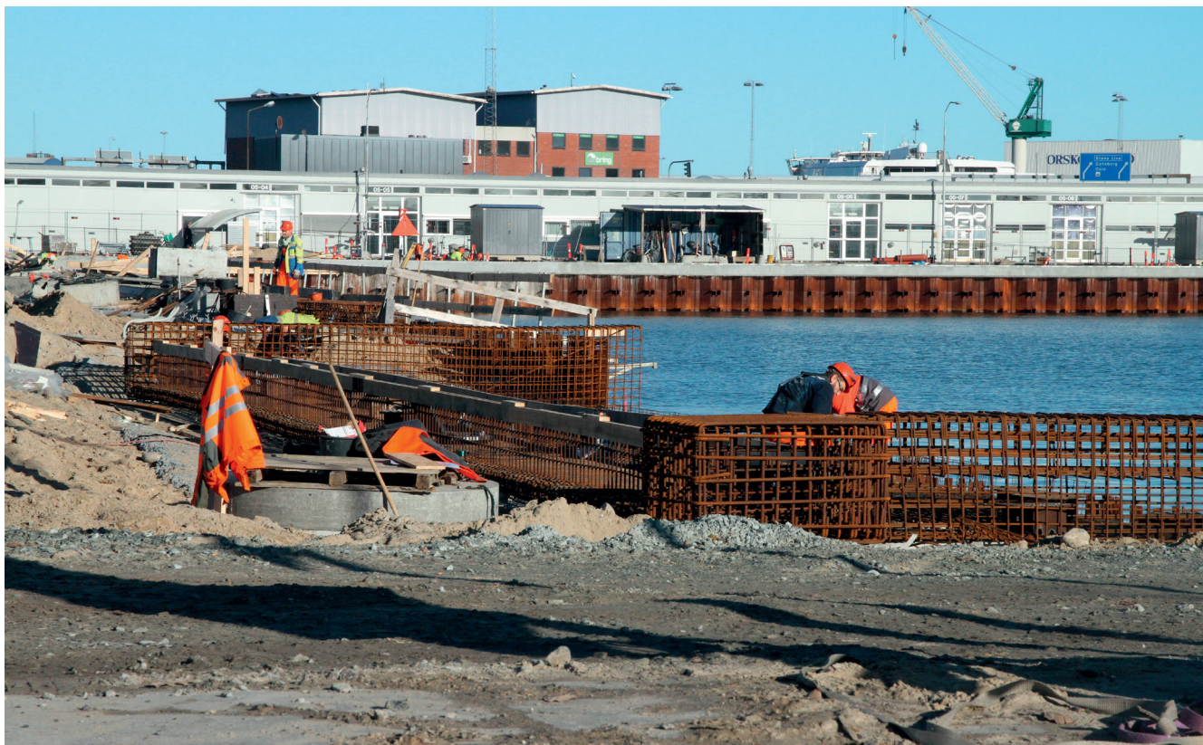
Renovering af kajanlæg ved Flådestation Frederikshavn. Foto: Martin Særmark-Thomsen.
